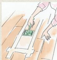
②埃を完全に取り去り、オスモカラーフロアークリアーをコテバケなどで薄く塗布する
